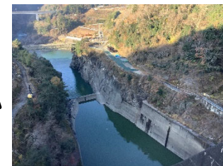
写真C 堤体(上流より下流を望む)
