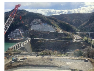
写真B 堤体(右岸より左岸を望む)
