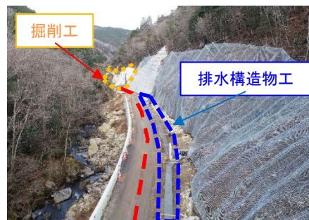
工事用道路造成
