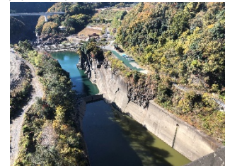
写真C 堤体(上流より下流を望む)
