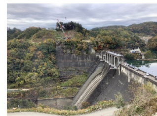
写真D 堤体(左岸より右岸を望む)
