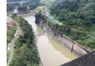
写真C 堤体(上流より下流を望む)
