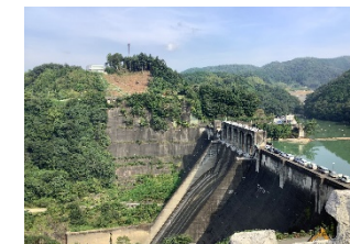
写真D 堤体(左岸より右岸を望む)
