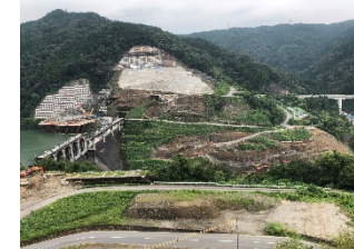
写真B 堤体(右岸より左岸を望む)
