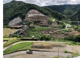
写真B 堤体(右岸より左岸を望む)
