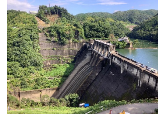
写真D 堤体(左岸より右岸を望む)
