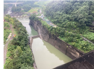
写真C 堤体(上流より下流を望む)
