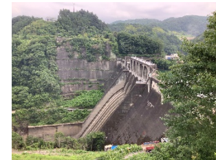
写真D 堤体(左岸より右岸を望む)
