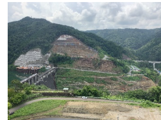
写真B 堤体(右岸より左岸を望む)
