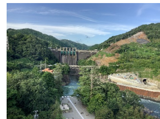
写真A 堤体(下流より上流を望む)
