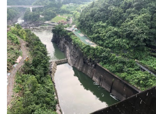
写真C 堤体(上流より下流を望む)
