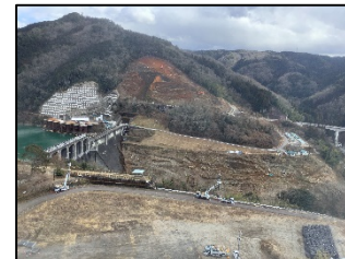
写真B 堤体(右岸より左岸を望む)
