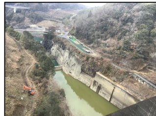
写真C 堤体(上流より下流を望む)
