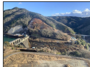
写真B 堤体(右岸より左岸を望む)
