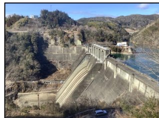
写真D 堤体(左岸より右岸を望む)
