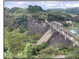
写真D 堤体(左岸より右岸を望む)
