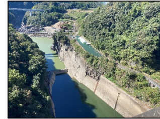
写真C 堤体(上流より下流を望む)
