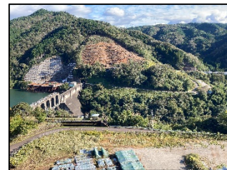
写真B 堤体(右岸より左岸を望む)
