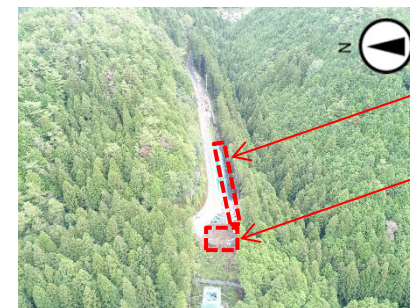
県道拡幅 A2橋台
