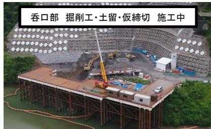
呑口部 掘削工・土留・仮締切 施工中
