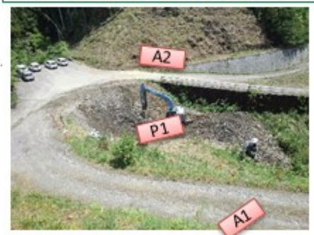
原石山線5号橋下部工事
