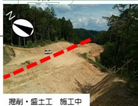
野中地区道路建設工事
