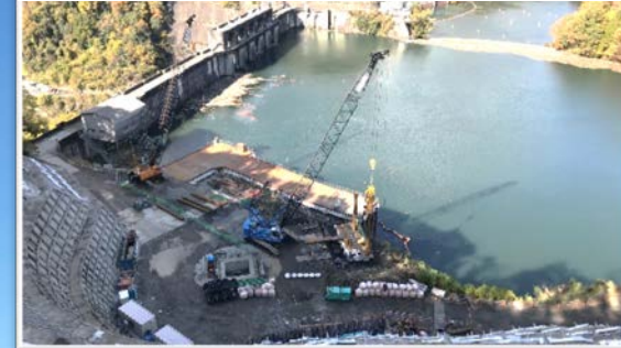
転流工【呑口部】仮栈橋工 施工中
