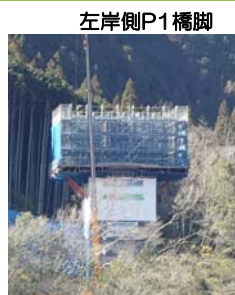
柱頭部施工状況
