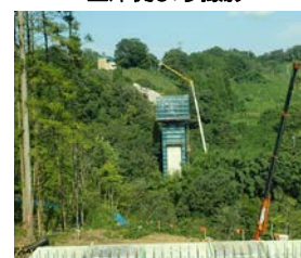
右岸側P2橋脚
