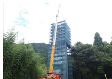
右岸側P2橋脚
