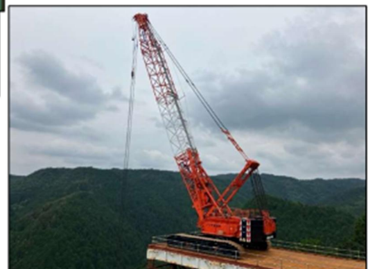
②120tクローラクレーン
