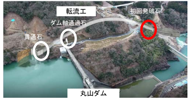
※転流工とは、ダム本体工事中に洪水を迂回させるトンネル水路です。
