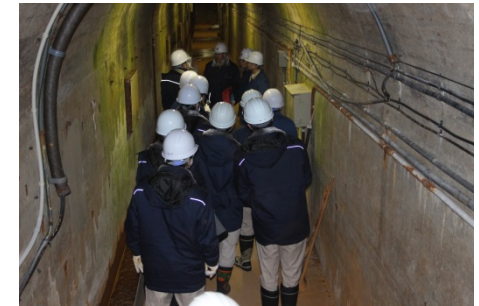
ダム内部にて
