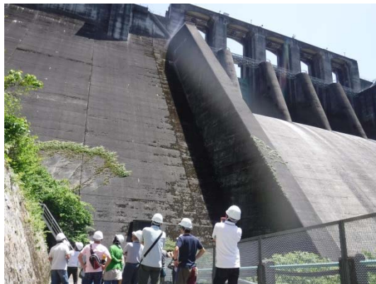
ダムの大きさに圧倒されます
