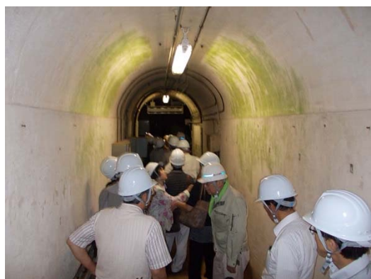
ダム内部にて
