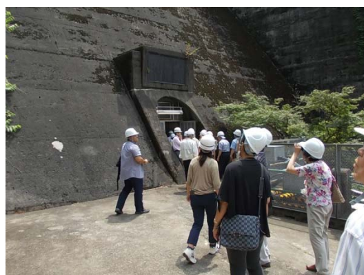
ダム内部へ向かいます
