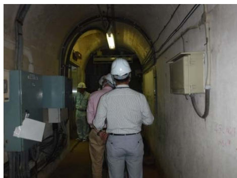
ダム内部にて
