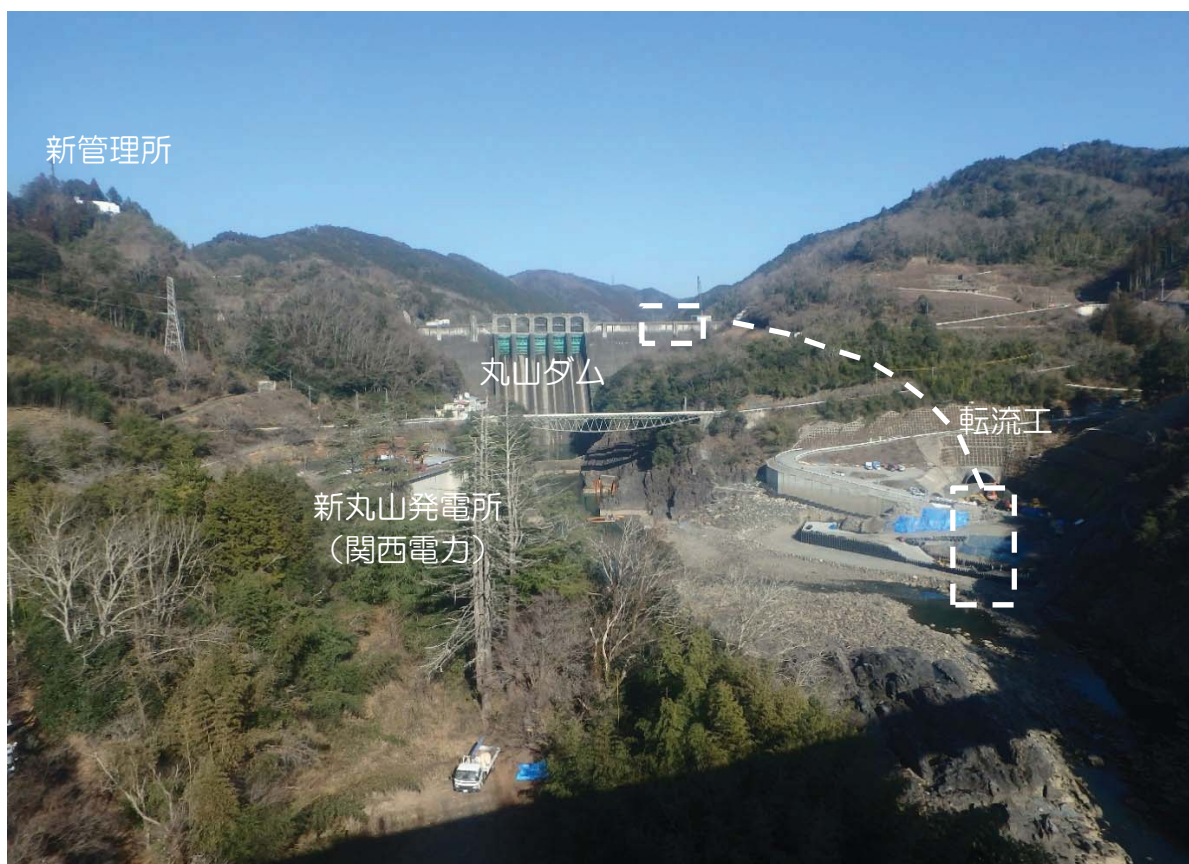
現況写真 (R3. 2. 22 撮影)
