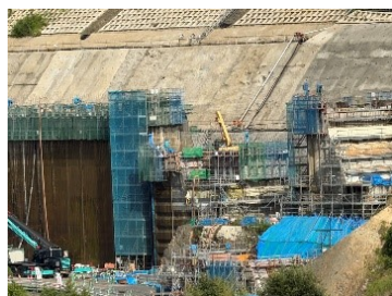
新丸山ダム減勢工付近
