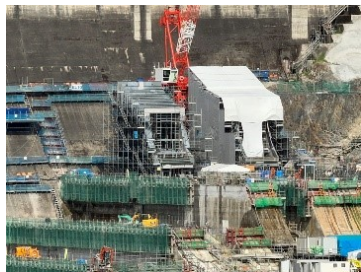
左岸常用洪水吐工事
