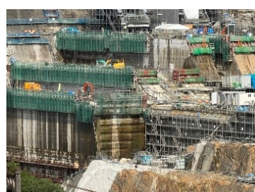
新丸山ダム左岸堤体付近
