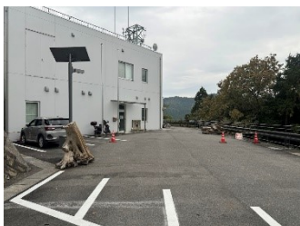
管理支所駐車場
