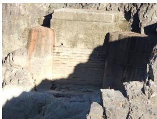
丸山ダム転流工
