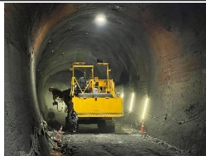
丸山ダム建設時の 転流工(激レア)
