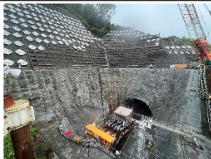
新丸山ダム転流工 呑口工事現場
