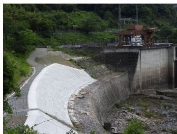
護岸工事済の右岸 ノーダメージ
