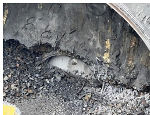
転流工貫通部拡大
