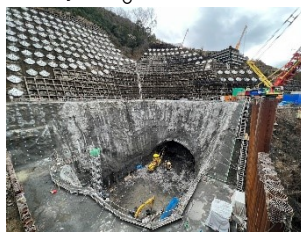
転流工 呑口全景
