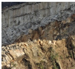
旧クレーン土台と岩盤か
