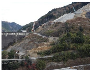
左岸掘削現場全景
