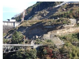
左岸掘削現場全景
