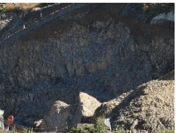
左岸掘削現場拡大写真
