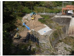
2022年10月23日工事状況
