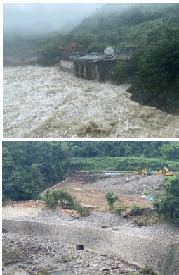
2021年8月被災状況
