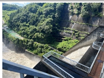
左岸背面点検橋入口付近より
