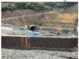
新丸山ダム転流工吐口
