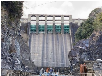
丸山ダムと調査風景
