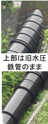
上部は旧水圧鉄管のまま 新水圧鉄管部分
