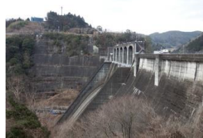
左岸から見た丸山ダム
