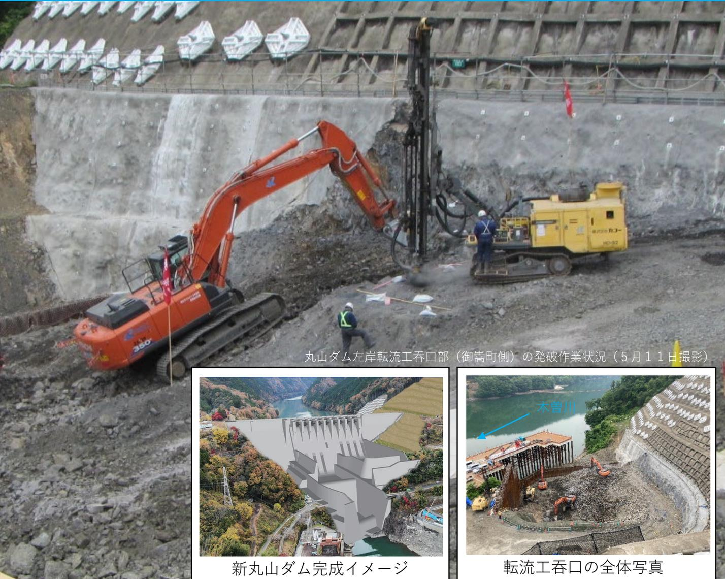
丸山ダム左岸転流工呑口部（御高町側）の発破作業状況（5月11日撮影）
