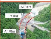
安全第一でダムコンクリート骨材運 搬道路の橋桁を架ける工事を行ってい ます。
