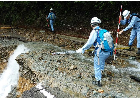
被災状況調査
