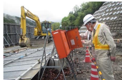
重機はもちろん電気設備も
