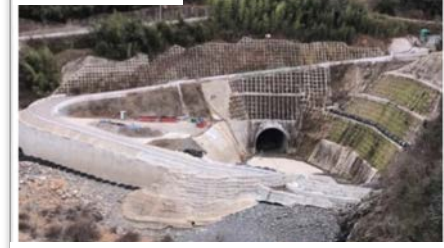
トンネル内基礎処理工 施工中
