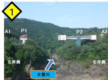
新小和沢橋上部工事
