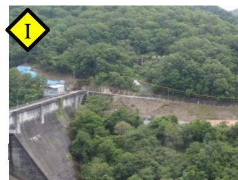
転流工進入路工事
