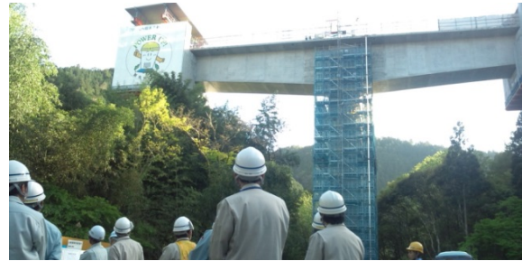
新丸山ダム付替道路工事の視察（新小和沢橋）
