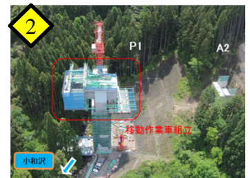
第2新小和沢橋上部工事
