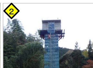
新小和沢橋上部工 (P2橋脚)
