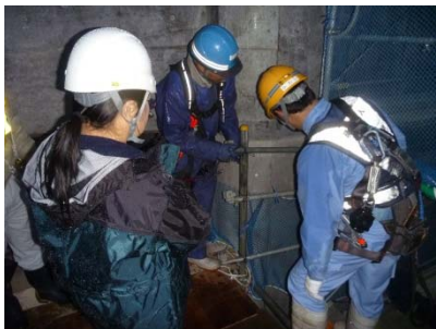
〈安全点検〉 工事現場の安全点検実施状況
