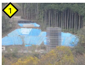
新小和沢橋P1橋脚
