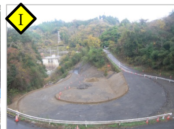
転流工進入路
