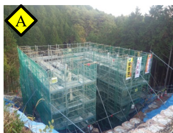
国道418号6号橋A1橋台
