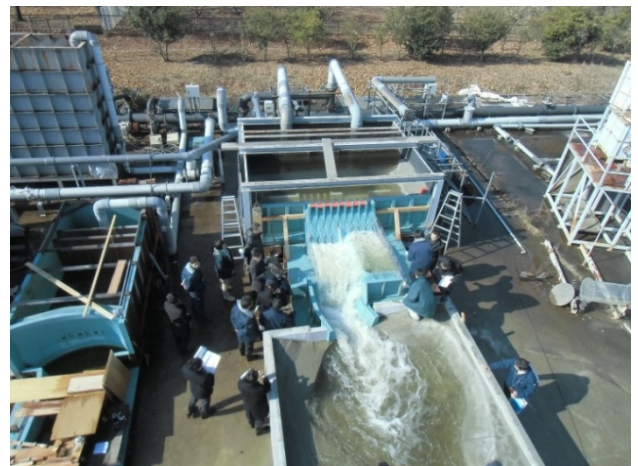
模型施設への通水状況
