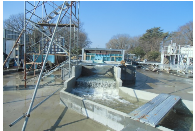
新丸山ダム水理模型実験施設（全体）
