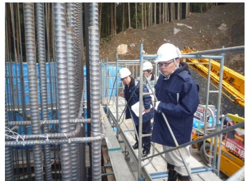
安全点検の状況
