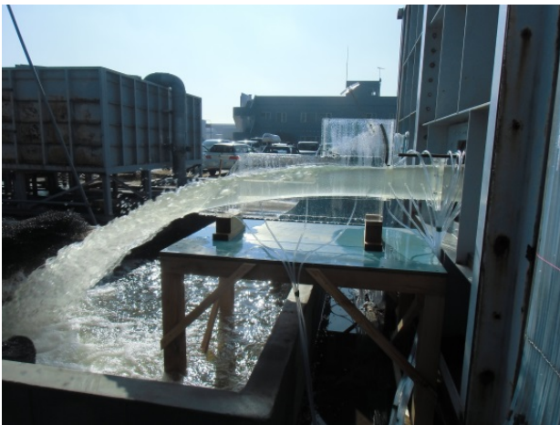
放流管（抽出実験）の放流状況
