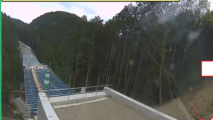
令和5年11月時点 床板コンクリート打設
