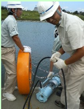
重さ35kgの排水ポンプを水中に沈めます。左のオレンジ色はフロートです。
