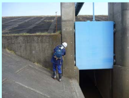
樋管の門柱調査
