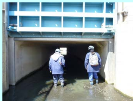
樋門内部状況調査
