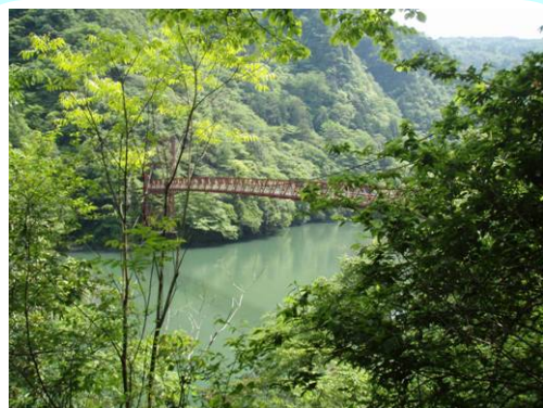
五月橋(右岸上流側から)
