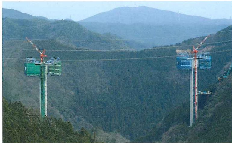
新旅足橋の進捗状況(平成20年3月23日現在)
