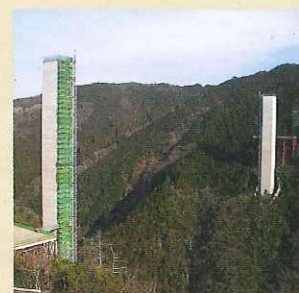
② 付替国道418号・新旅足橋(左右岸)
