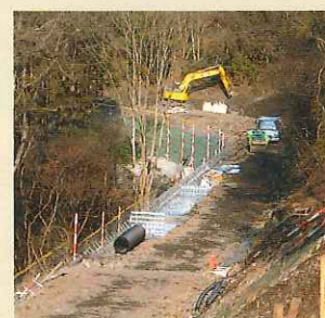
① 工事用道路・資材運搬線
