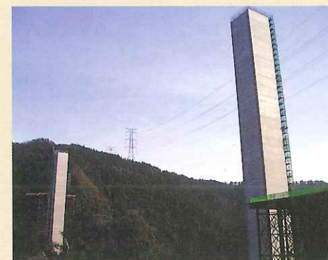
下部工工事完了状況(平成19年2月)
