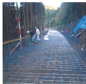
① 工事用道路・資材運搬線 [御嵩町大久後]
