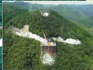
最新工事状況【右岸】 (平成17年9月撮影)
