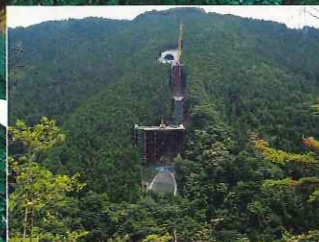
最新工事状況【左岸】 (平成17年9月撮影)
