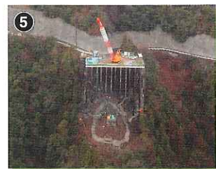
⑤ 付替国道418号・新旅足橋 (右岸) [八百津町小洞]
