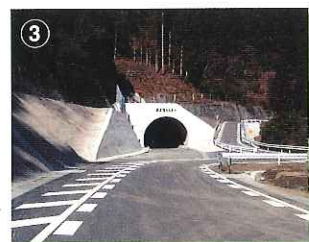
③ 資材運搬線・大久後トンネル [御高町大久後]
