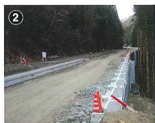
② 資材運搬線 [御高町大久後]
