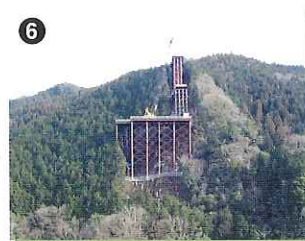
⑥ 付替国道418号・新旅足橋 (左岸) [八百津町牛首]
